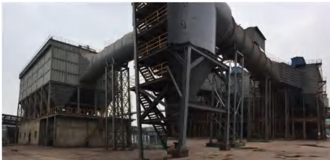
图 8.1-3 低压脉冲布袋除尘器
